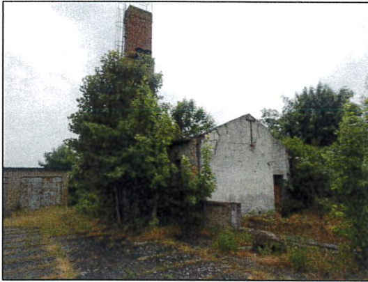
Bild 1: Gebäudeansicht Heizhaus von Westen.
