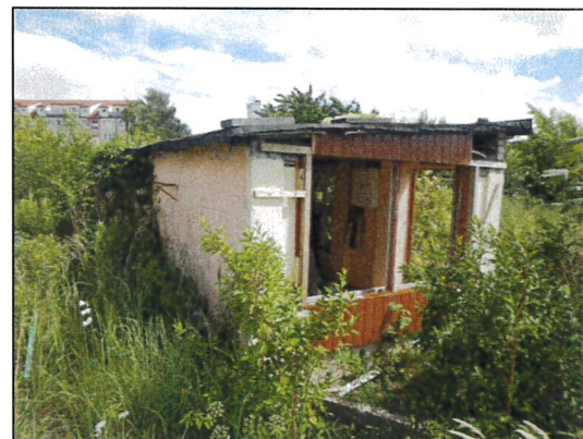
Bild 12: Gebäudeansicht Laube V von Westen.
