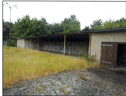
Bild 2: Gebäudeansicht Garagenkomplex (Südflügel) von Osten.
