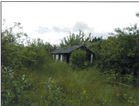
Bild 11: Gebäudeansicht Laube G von Nordwesten.
