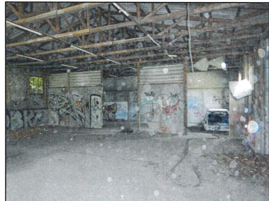
Bild 8: Innenansicht Lagerhalle II.
