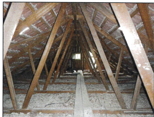
Bild 42: Wohnhaus II, Dachbodenansicht.
