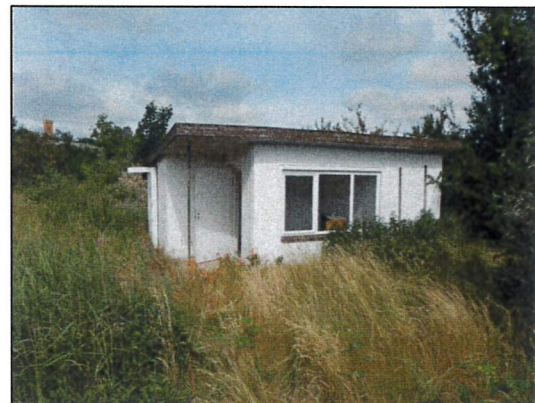
Bild 10: Gebäudeansicht Laube B von Osten.
